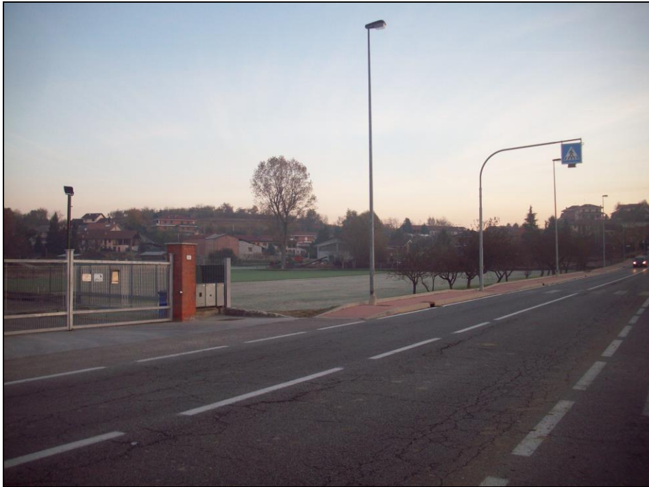
1. Vista strada provinciale 119 ante intervento
