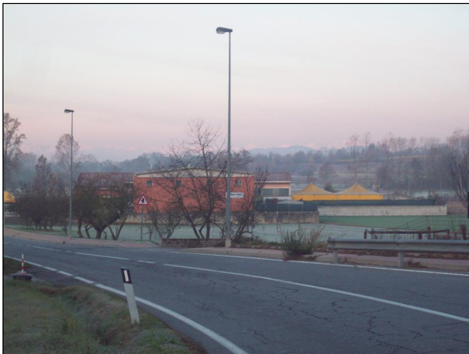
3. Vista lato strada comunale del Mulino del lago – ante intervento
